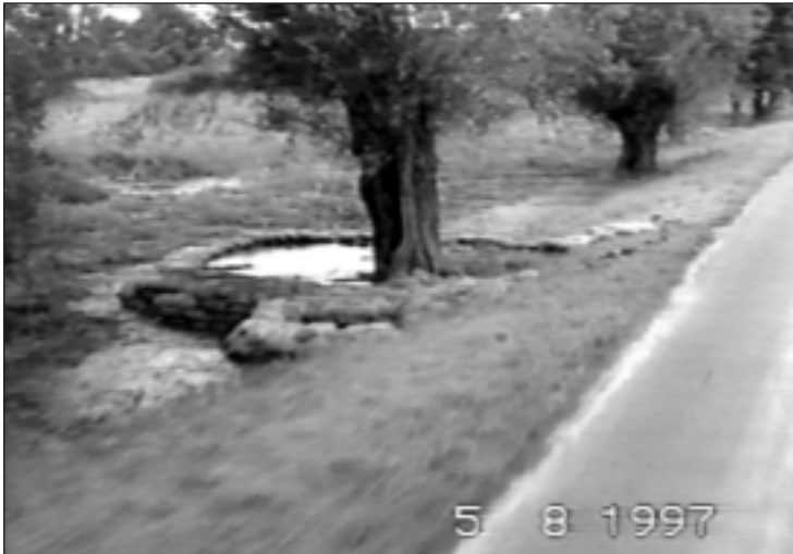
Abb. 24: Ringdeiche um Bäume deuten auf in Baumnähe verstärkten Wasseraustritt vermutlich entweder durch den Pipe-Effekt fauler Wurzeln oder die Pumpwirkung der Baumwurzeln bei Windbewegung (aus einem Video, das freundlich von Herrn Papke, Umweltamt Brandenburg, überlas- sen wurde, dem dafür hier sehr gedankt sei).
